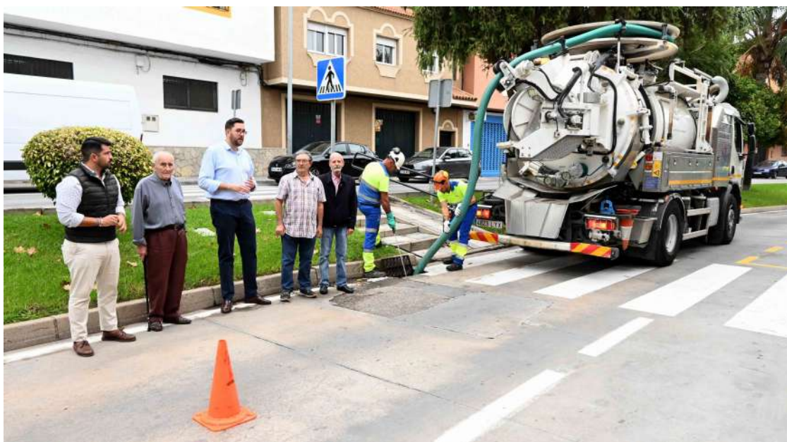
LIMPIEZA DE IMBORNALES DE AGUA MARINA
