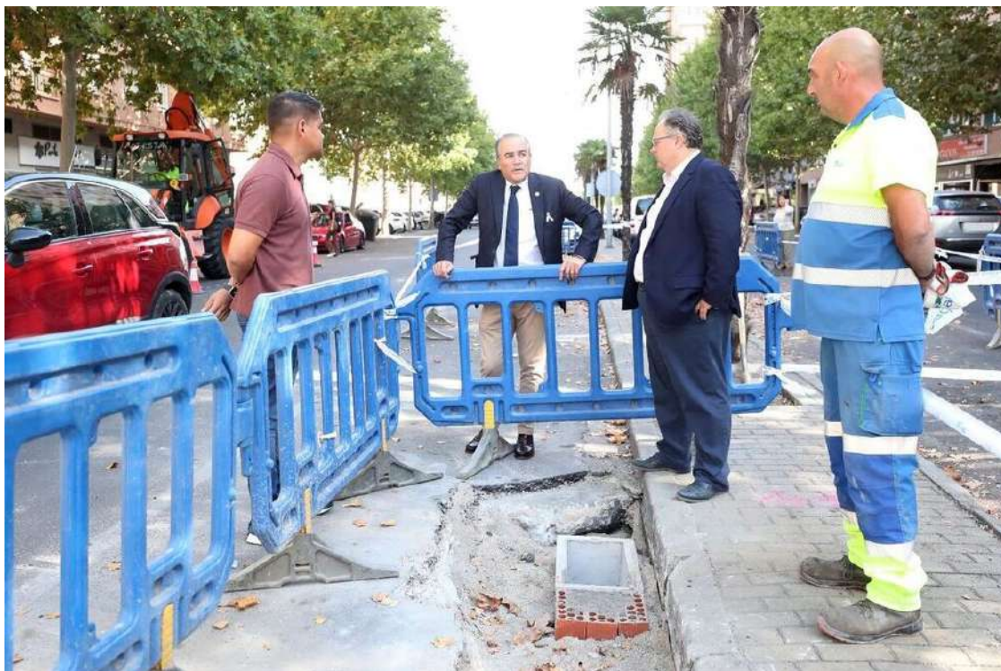
Talavera instala nuevos imbornales para evitar balsas de agua - Foto: L.T.
