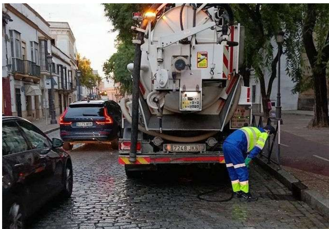
Un operario de Aquajerez en las tareas de limpieza de alcantarillas e imbornales ante la previsión de lluvias. - AYUNTAMIENTO DE JEREZ
