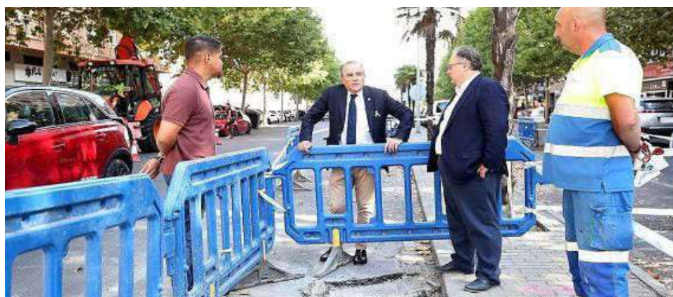
Gregorio y García supervisan los trabajos de los nuevos imbornales en la avenida de la Constitución. /L.T.
